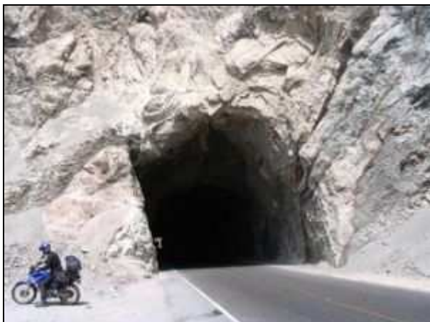
Aberto a machadadas.
